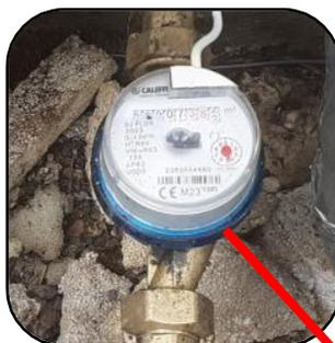
1) un nuovo contatore a impulsi a valle dell'esistente fornisce il conteggio dei consumi al sistema
