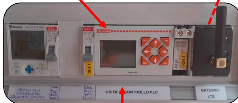
2) il PLC, attivandosi nell'intervallo di tempo definito da un orologio settimanale, conteggia i consumi durante le ore notturne: se superano una soglia stabilita, attraverso il gateway LTE invia una notifica tramite app a dispositivi mobili remoti
